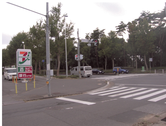
図2 A点設置場所
