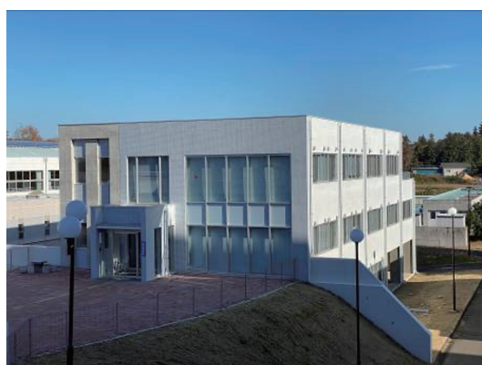
図1 総合研究棟外観
