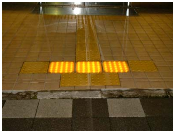
図3 高輝度LED内蔵型の点字ブロック (株式会社タナビホームページより)
