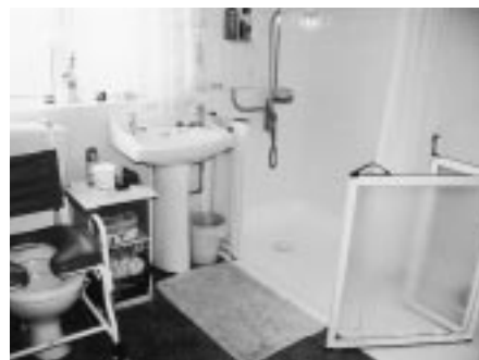
写真3. シャワールームを改修
