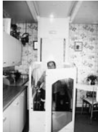
写真1. 食堂の一部に設置したリフト
